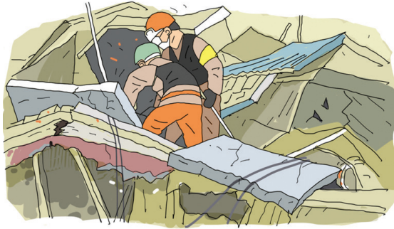
진주 리모델링 공사중 사고(2016. 8. 28)
